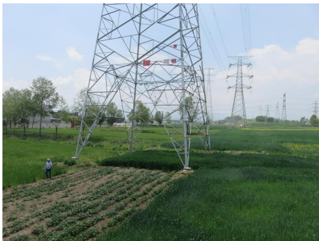
继管线 37#、恒康线 15#塔基区复垦恢复状
