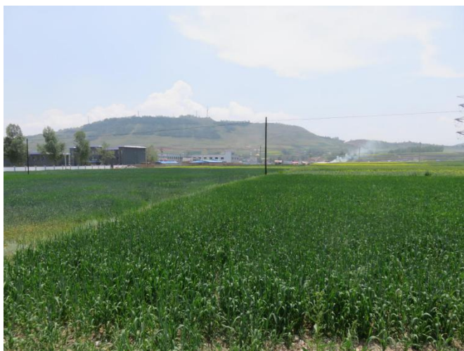
施工 31#~32#杆间牵张场恢复状
