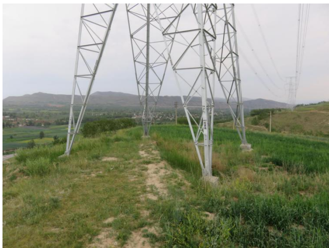
继营线 32#、恒康线 20#塔基区种草恢复状
