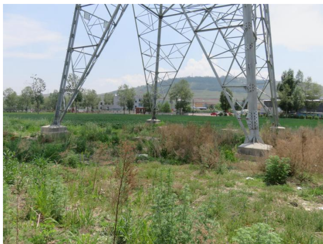
继管线 39#、恒康线 13#塔基区复垦恢复状
