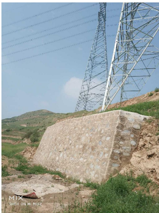
继管线 16#、恒康线 36#塔基区挡土墙
