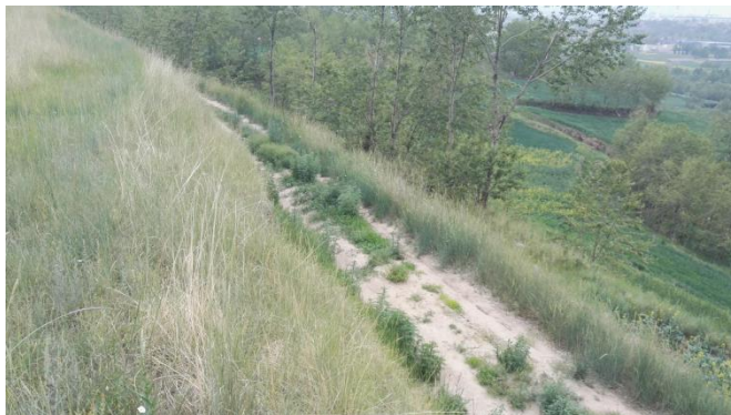
继管线 29#、恒康线 23#塔利用农耕道路状
