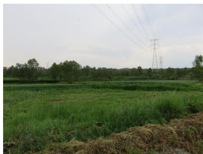
施工 18#~19#杆间牵张场恢复状
