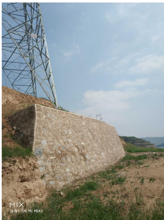
继管线 17#、恒康线 35#塔基区挡土墙
