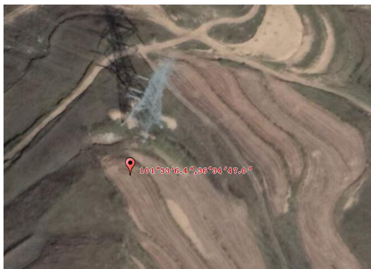
恒康线 44#、继营线 08#塔基区施工期遥感照片
