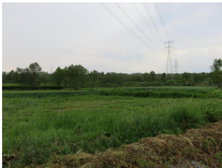
施工 18#~19#杆间牵张场恢复状
