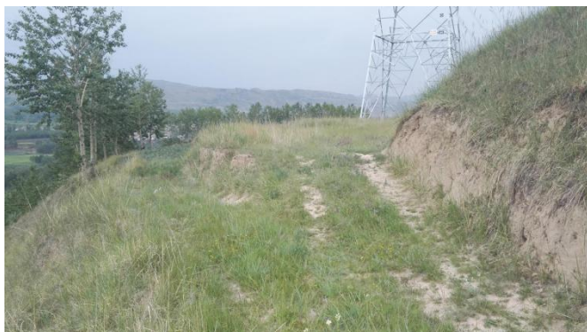
继管线 31#、恒康线 21#塔利用农耕道路恢复状
