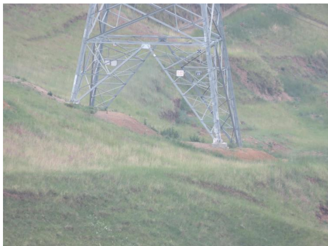
继管线 07#、恒康线 45#塔基区种草恢复状
