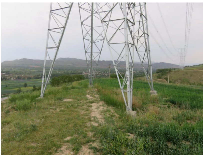
继营线 32#、恒康线 20#塔基区种草恢复状
