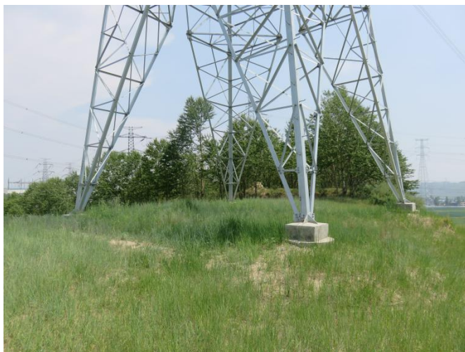
恒康线 11#塔基区种草恢复状
