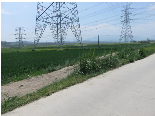
继管线 38#、恒康线 14#塔利用机耕道及田间路恢复状
