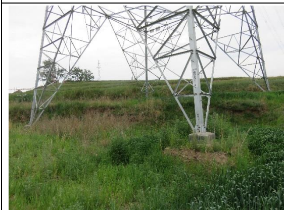
塔基区植被恢复
