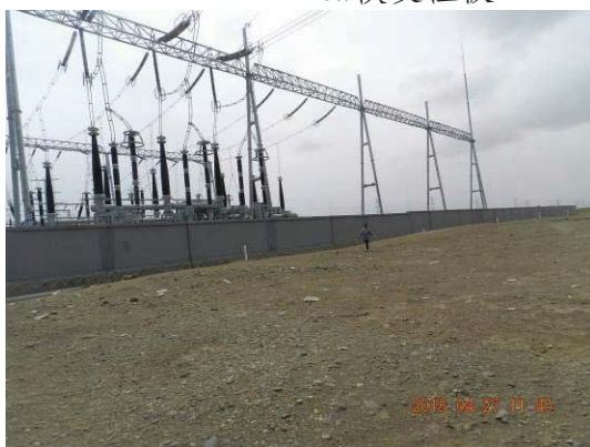
牵张场碎石压盖
