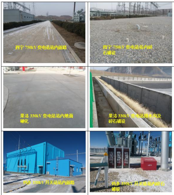
图 6.5 本工程变电站和开关站变电站水土保持情况
