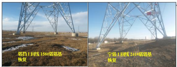
图6.3 塔基生态恢复情况
