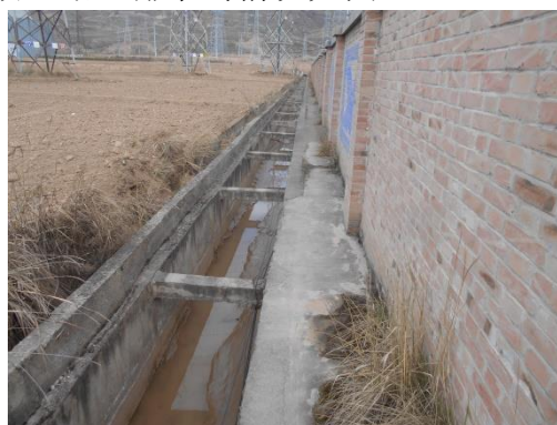
图 6.2-6 边坡防护情况
