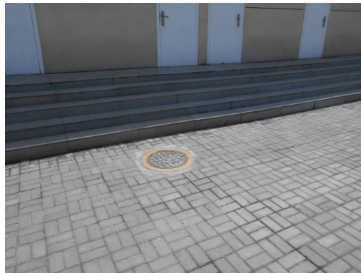
图 9.2-1 花园变电站化粪池
