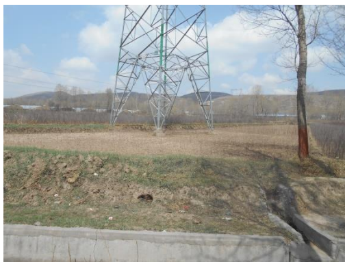
图 6.2-4 施工便道恢复情况
