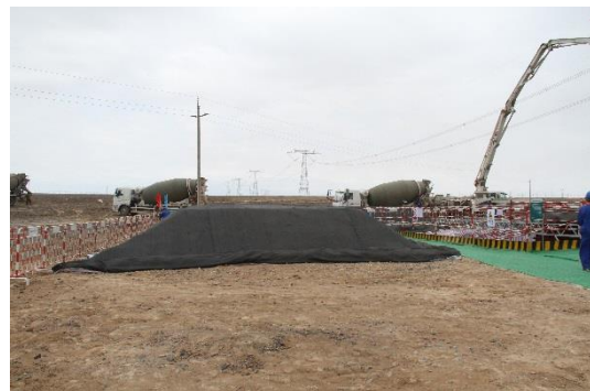
剥离表土、临时苫盖、临时隔离、临时拦挡
