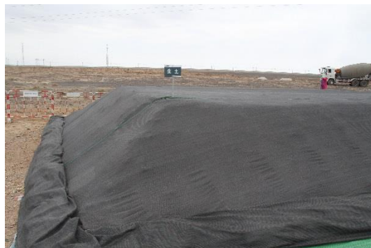
剥离表土、临时苫盖、临时隔离、临时拦挡
