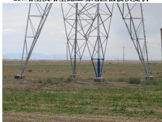
25#塔基及塔基施工场地区植被恢复状
