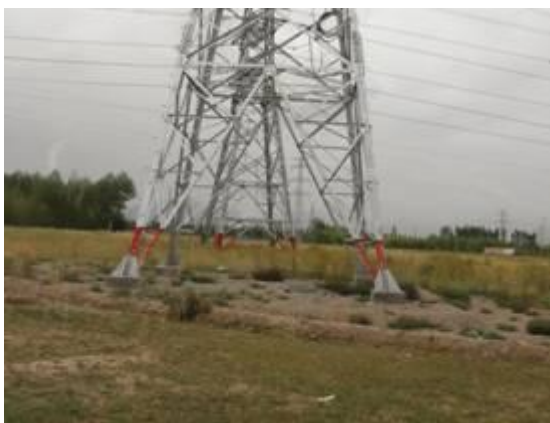
改线 001#塔基及施工场地区整治恢复状
