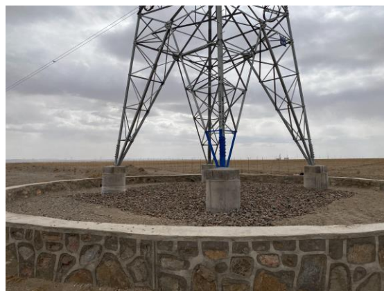
30#塔基区砾石压盖
