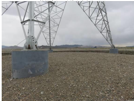
13#塔基区砾石压盖
