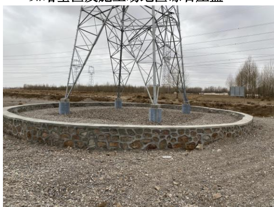
11#塔基挡土墙及砾石压盖
