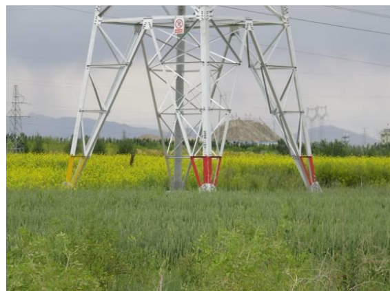
改线 002#塔基及施工场地区土地整治复耕状
