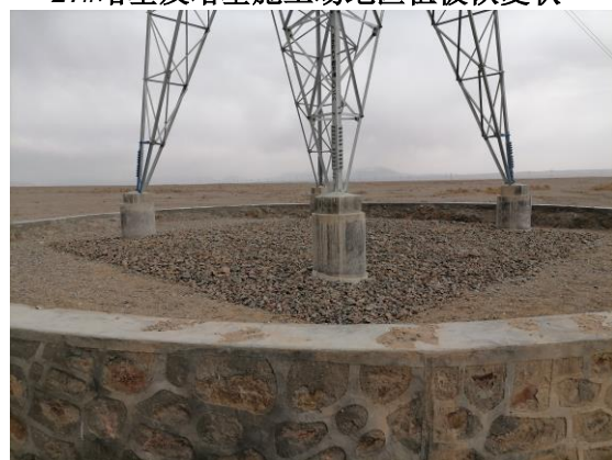
28#塔基区砾石压盖
