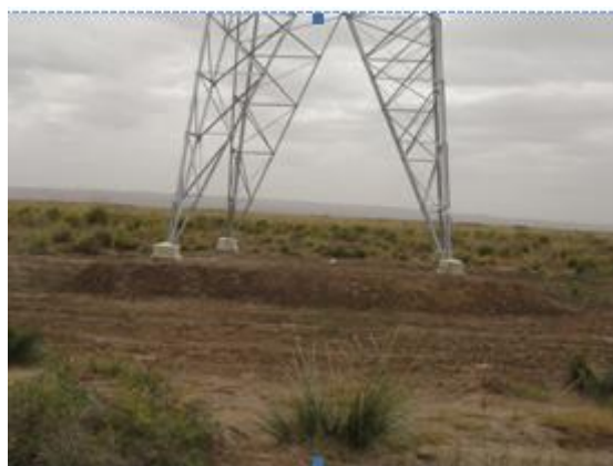
58#塔基及塔基施工场地区植被恢复状
