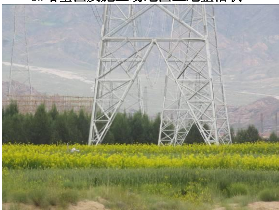
10#塔基区及施工场地区土地整治复耕状
