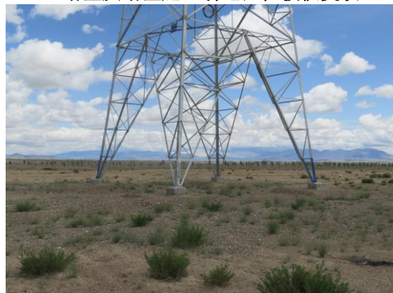
21#塔基及塔基施工场地区植被恢复状
