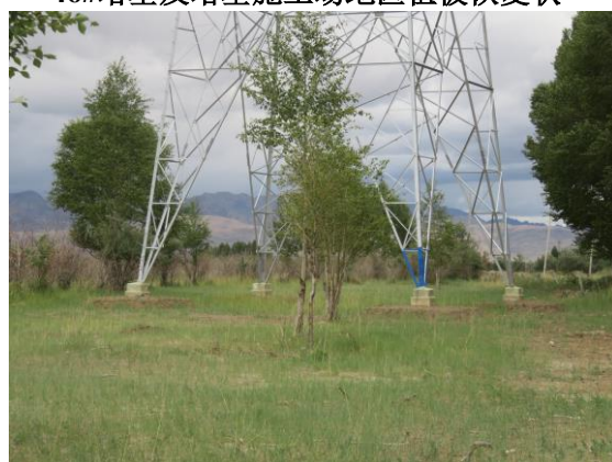
48#塔基及塔基施工场地区植被恢复状
