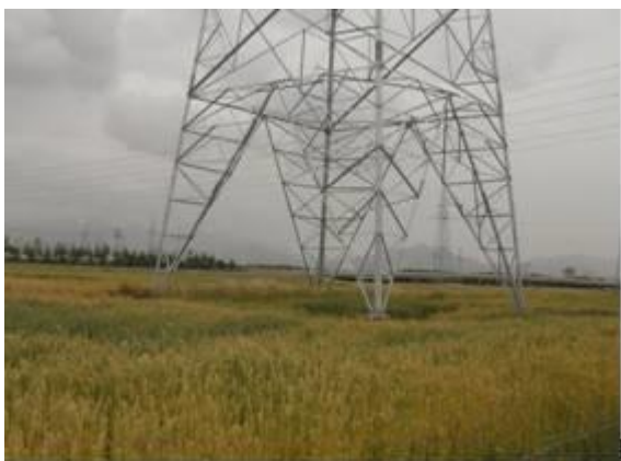
6#塔基区及施工场地区土地整治复耕状
