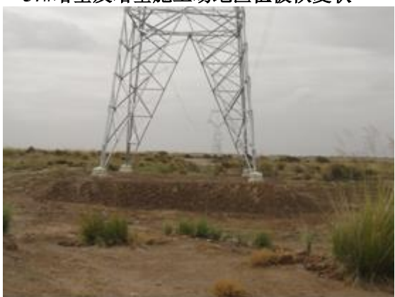
59#塔基及塔基施工场地区植被恢复状
