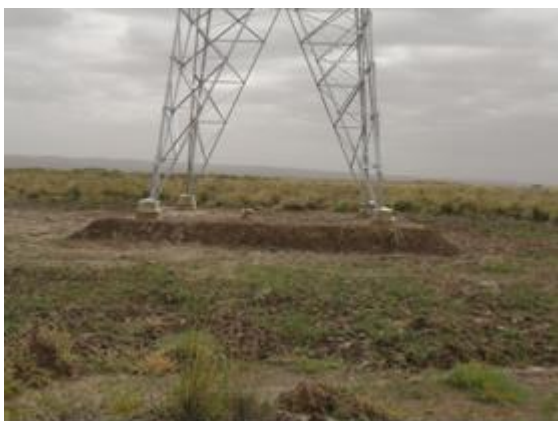
57#塔基及塔基施工场地区植被恢复状
