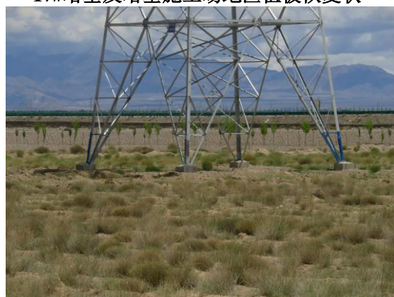
19#塔基及塔基施工场地区植被恢复状
