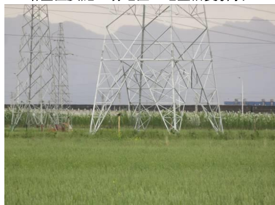
5#塔基区及施工场地区土地整治复耕状
