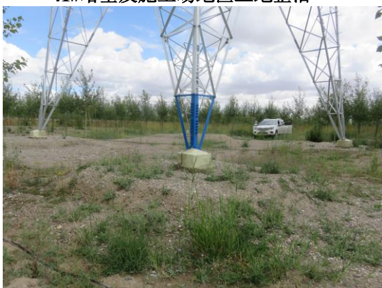
43#塔基及施工场地区植被恢复状
