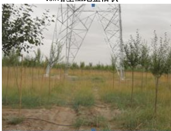
42#塔基及施工场地区植被恢复状
