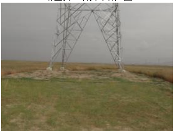
39#塔基植被恢复状
