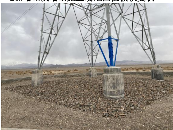
27#塔基区砾石压盖
