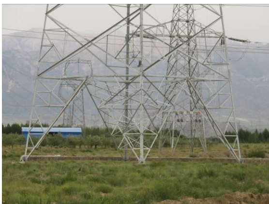
14#塔基及塔基施工场地区植被恢复状
