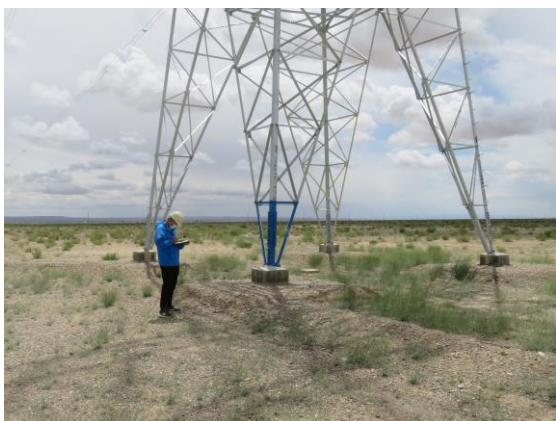
22#塔基及塔基施工场地区植被恢复状
