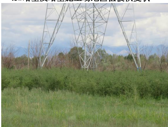
47#塔基及塔基施工场地区植被恢复状
