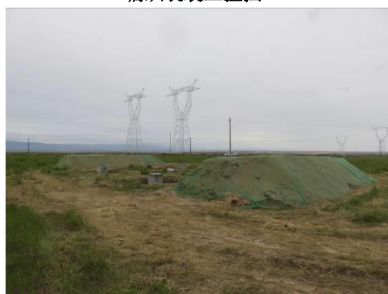
密目网临时苫盖
