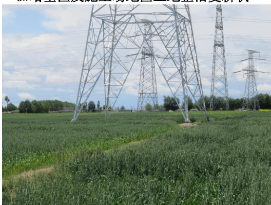
8#塔基区及施工场地区土地整治状
