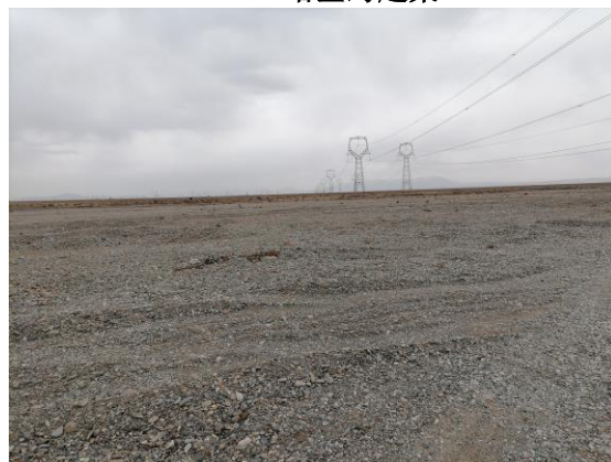
牵张场区整治状
