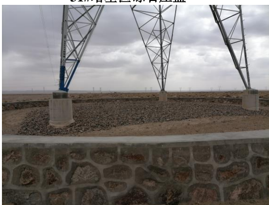
33#塔基区砾石压盖
