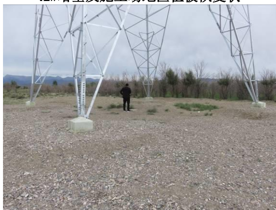
44#塔基及塔基施工场地区砾石压盖
