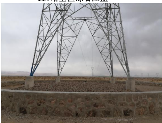
35#塔基区砾石压盖
