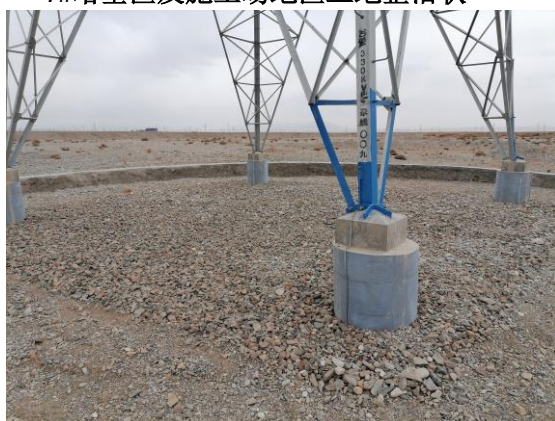
9#塔基区及施工场地区砾石压盖
