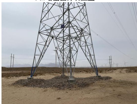
95#塔基区碎石压盖
