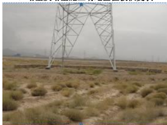
17#塔基及塔基施工场地区植被恢复状
