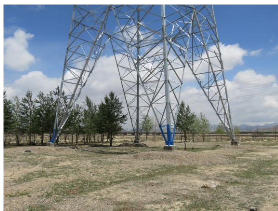
7#塔基区及施工场地区土地整治状
