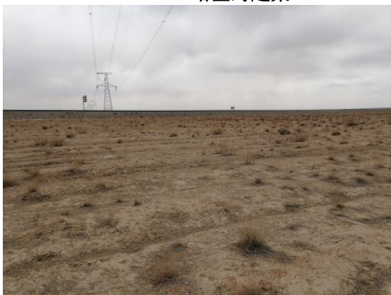
跨越施工场地区整治恢复状
