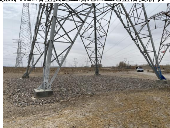
1#塔基区及施工场地区砾石压盖
