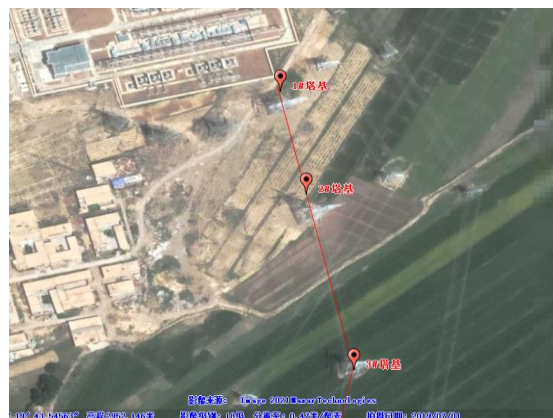
1、2、3 塔基 2019 年 7 月组塔施工遥感影像
