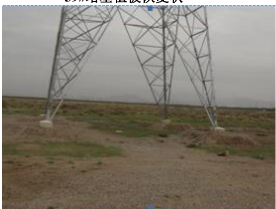
41#塔基及施工场地区土地整治
