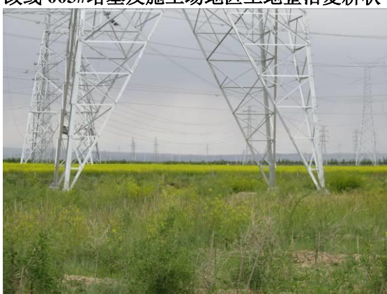
2#塔基区及施工场地区土地整治状
