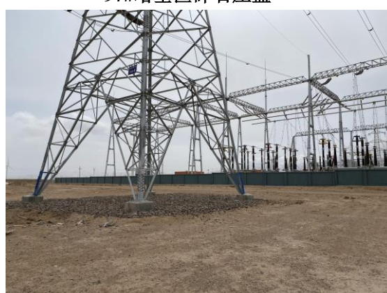
100#塔基区碎石压盖
