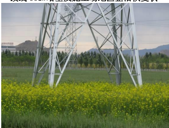
改线 003#塔基及施工场地区土地整治复耕状
