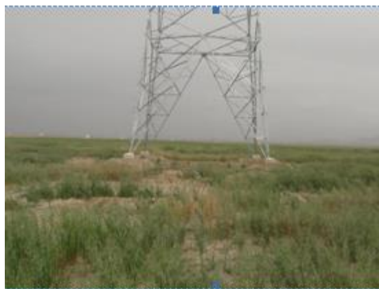
38#塔基植被恢复
