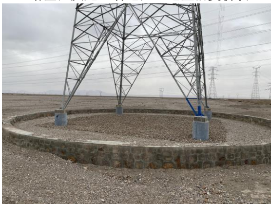
12#塔基区砾石压盖
