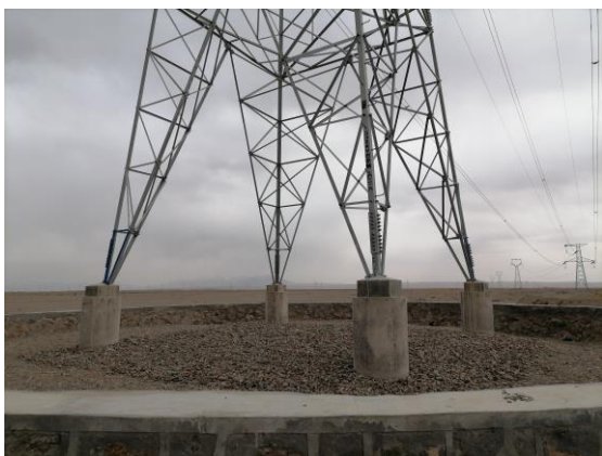
29#塔基区砾石压盖
