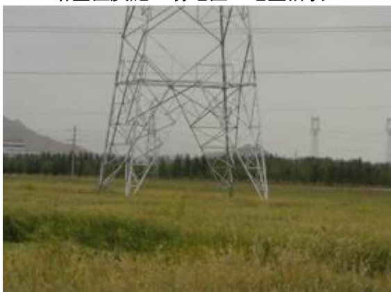
4#塔基区及施工场地区土地整治复耕状
