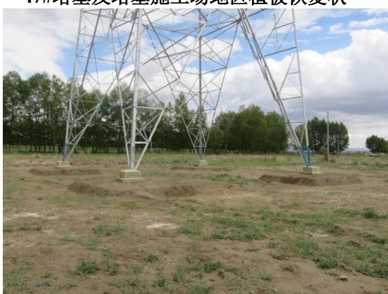
49#塔基及塔基施工场地区植被恢复状
