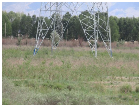
46#塔基及塔基施工场地区植被恢复状
