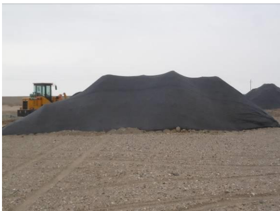
临时密目网苫盖
