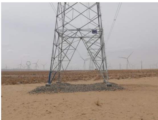
96#塔基区碎石压盖
