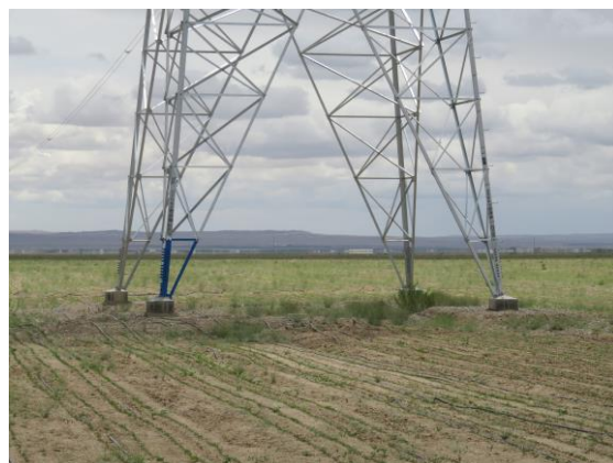
23#塔基及塔基施工场地区植被恢复状
