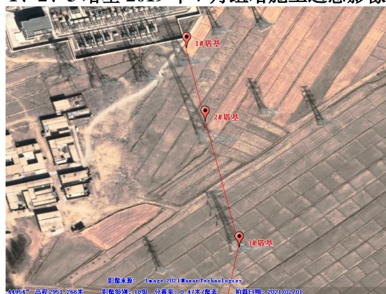
1、2、3 塔基 2021 年 2 月组塔施工遥感影像
