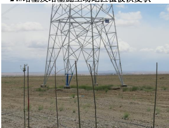
26#塔基及塔基施工场地区植被恢复状
