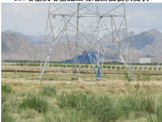
18#塔基及塔基施工场地区植被恢复状
