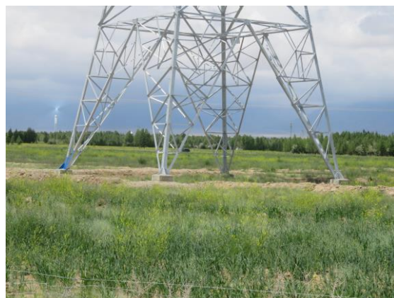
15#塔基及塔基施工场地区植被恢复状
