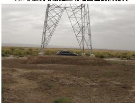
60#塔基及塔基施工场地区植被恢复状
