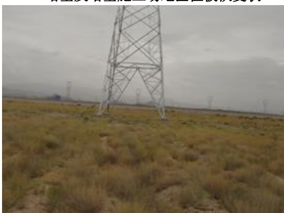
16#塔基及塔基施工场地区植被恢复状
