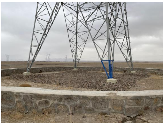
37#塔基挡土墙及砾石压盖
