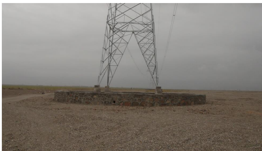
图 2.4-2 塔基区防洪墙挡护
