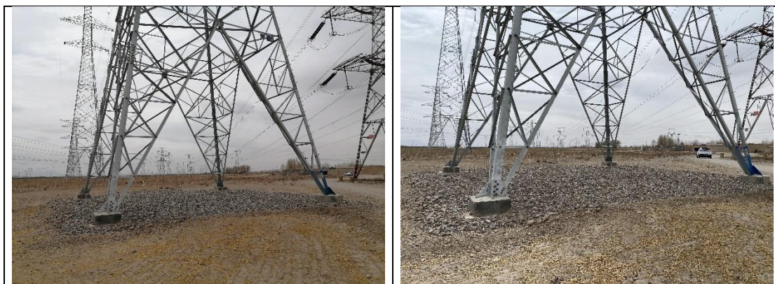
1#塔基：土地整治后采取碎石压盖措施
