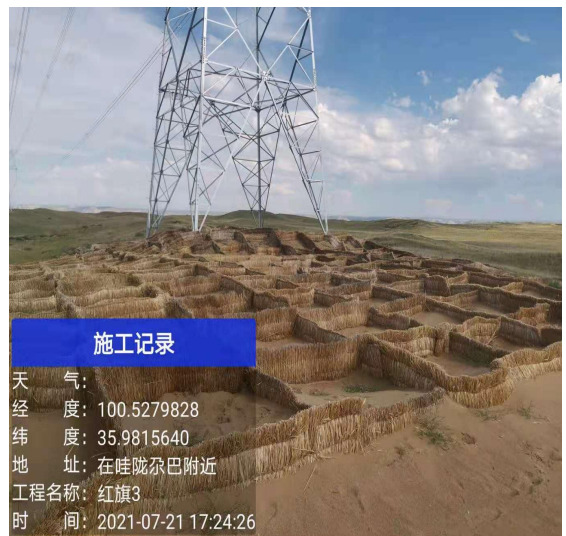
沙化区域石方格防风固沙及植被恢复措施
