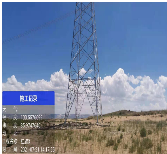
沙化区域石方格防风固沙及植被恢复措施
