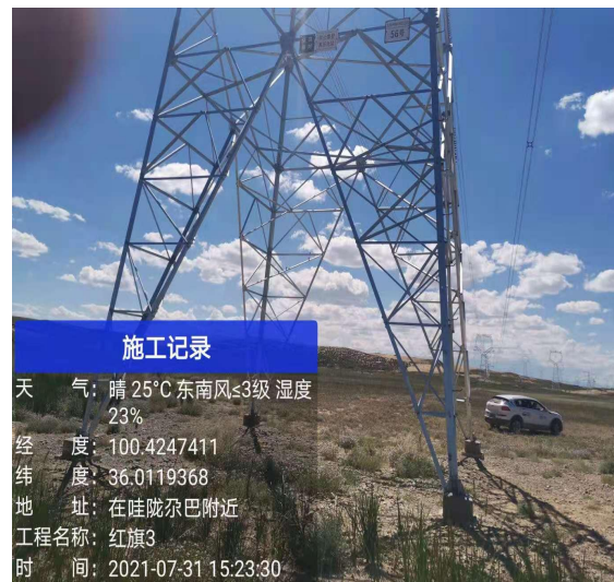
植被成活率及生长较好塔基
