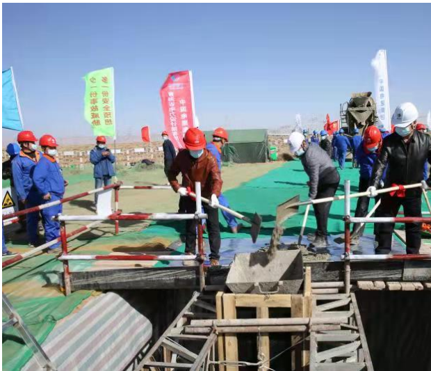
地面苫布苫盖施工
