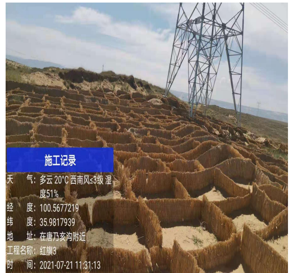
植被成活率及生长较好塔基
