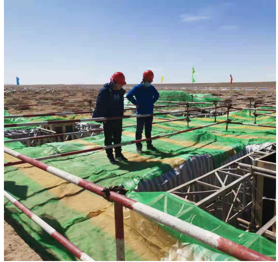
地面苫布苫盖施工
