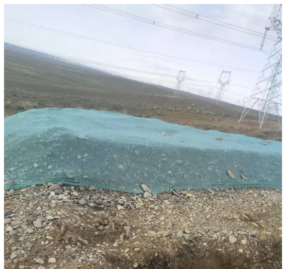
堆放砂石防尘网苫盖
