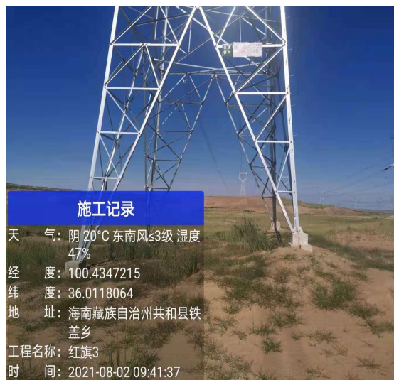
植被成活率及生长较好塔基
