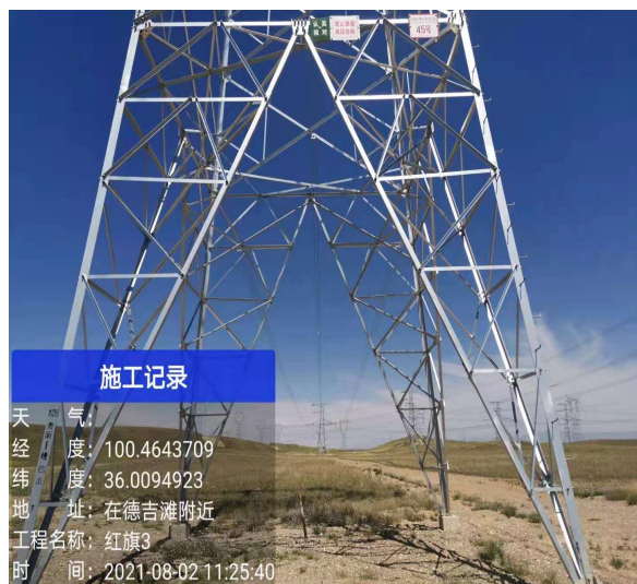
植被成活率及生长较好塔基
