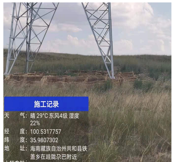
植被成活率及生长较好塔基
