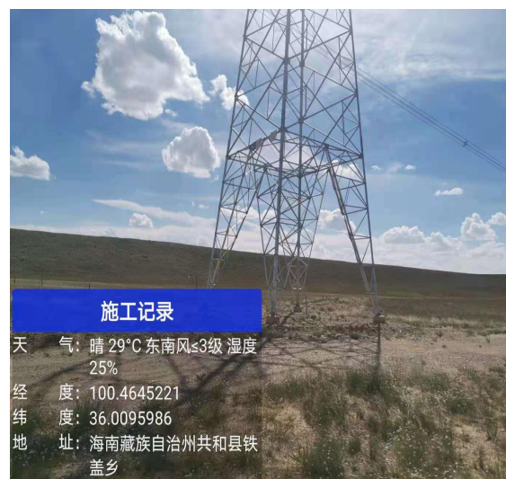
植被成活率及生长较好塔基
