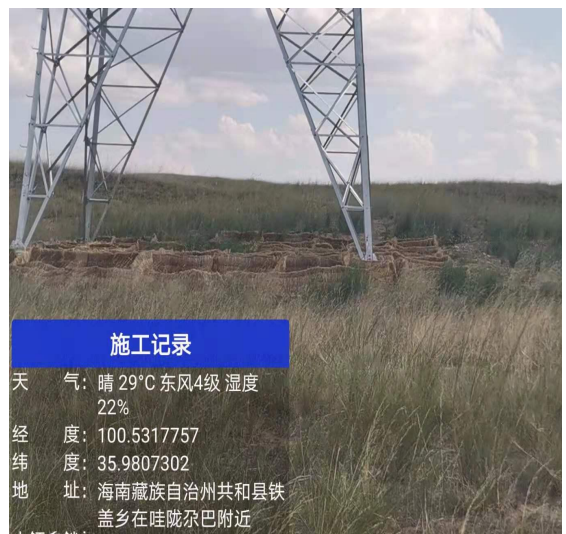
植被成活率及生长较好塔基
