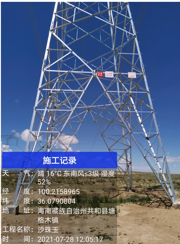
植被成活率及生长较好塔基
