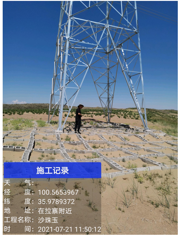
沙化区域石方格防风固沙及植被恢复措施
