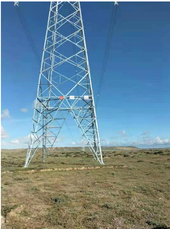
区域植被生长较好的塔基
