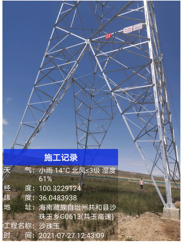
植被成活率及生长较好塔基
