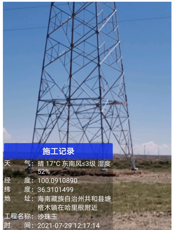
植被成活率及生长较好塔基
