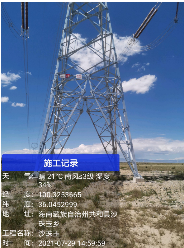
植被成活率及生长较好塔基
