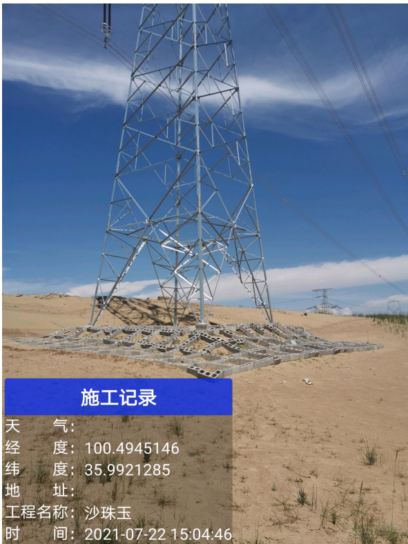
沙化区域石方格防风固沙及植被恢复措施
