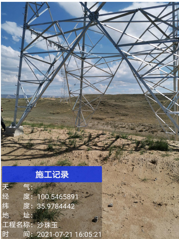
植被成活率及生长较好塔基
