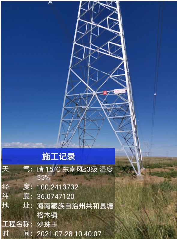
植被成活率及生长较好塔基
