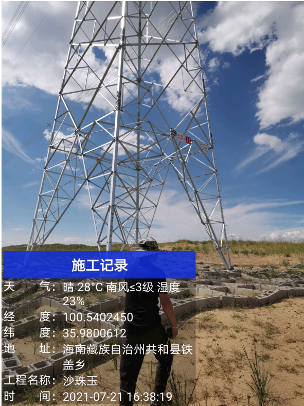
沙化区域石方格防风固沙及植被恢复措施
