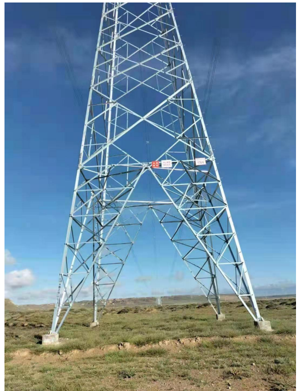
区域植被生长较好的塔基
