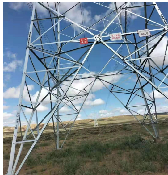
塔基四周植被恢复情况
