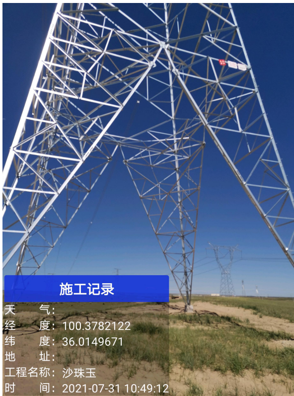
植被成活率及生长较好塔基
