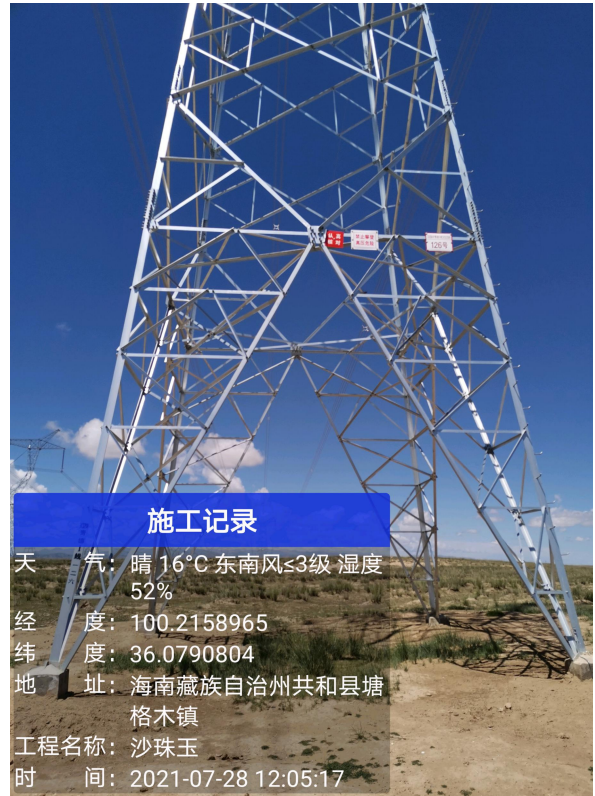
植被成活率及生长较好塔基
