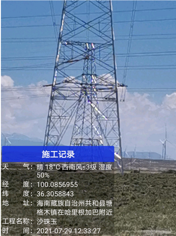
植被成活率及生长较好塔基
