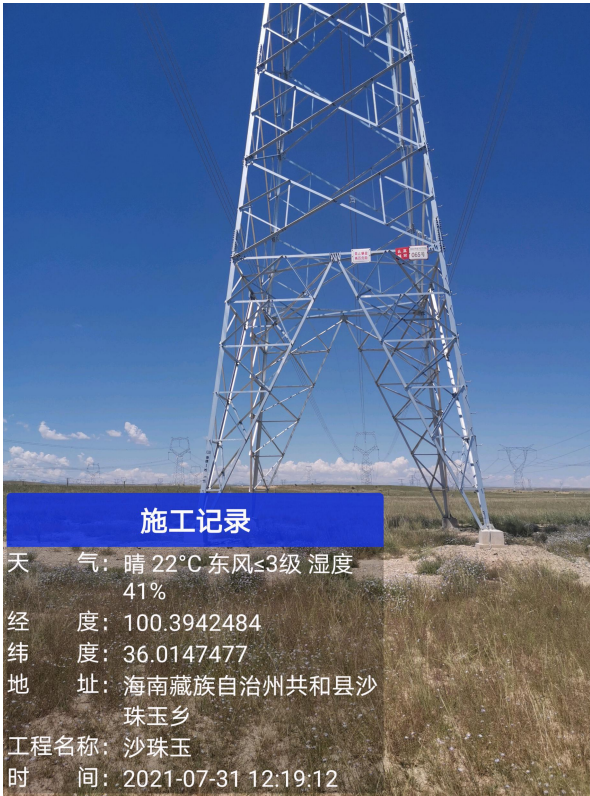
植被成活率及生长较好塔基
