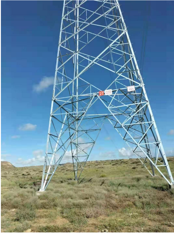
区域植被生长较好的塔基
