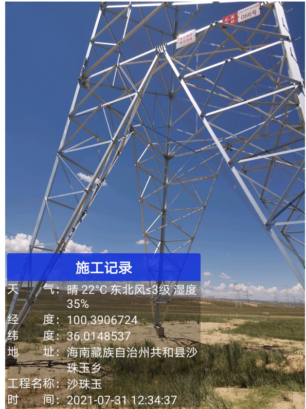
植被成活率及生长较好塔基
