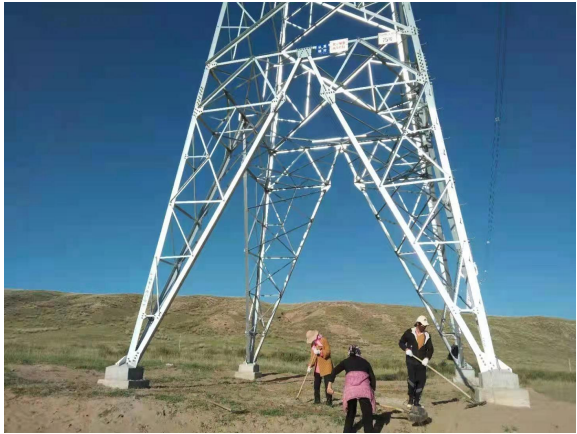
环水保护措施施工总包方施工图片
