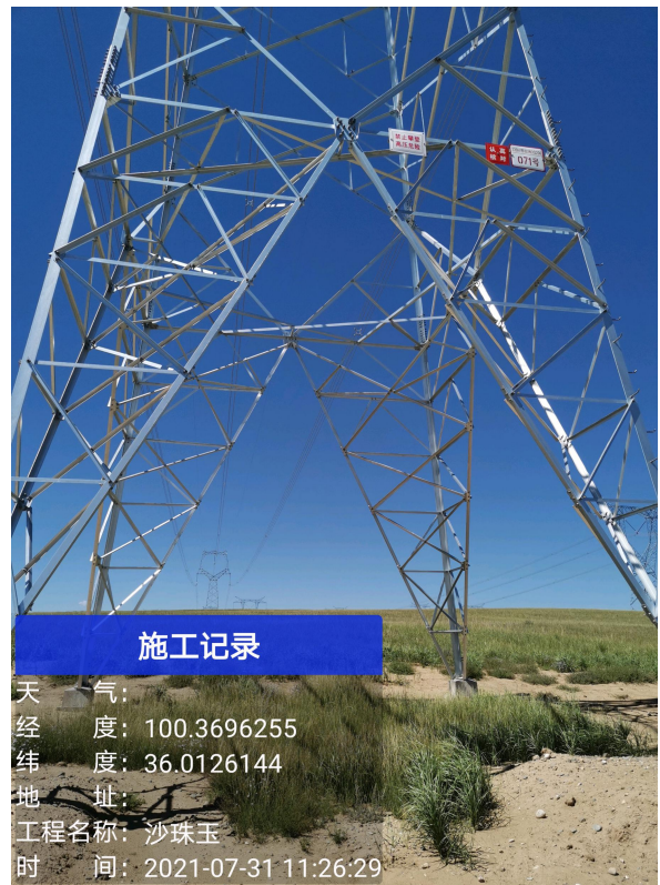
植被成活率及生长较好塔基
