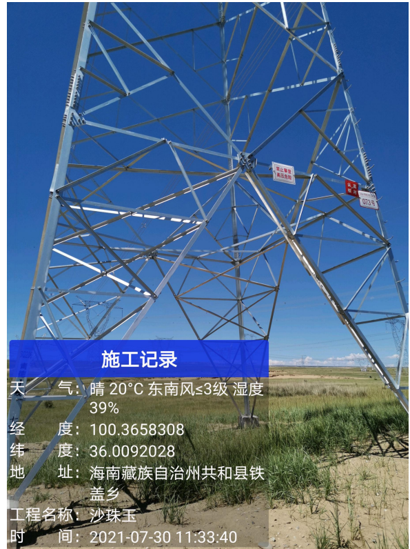
植被成活率及生长较好塔基
