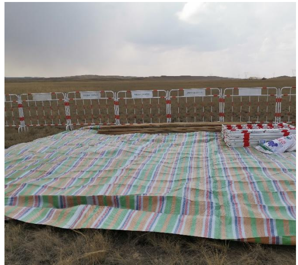
项目施工中划定施工范围线
