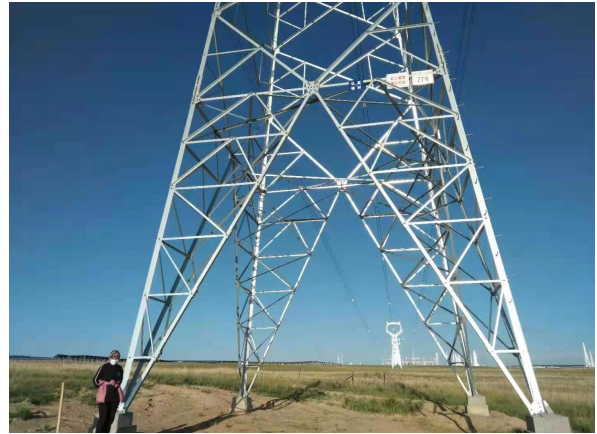
环水保护措施施工总包方施工图片
