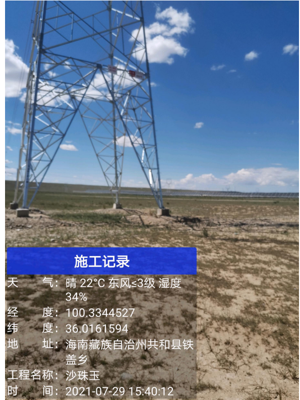
植被成活率及生长较好塔基
