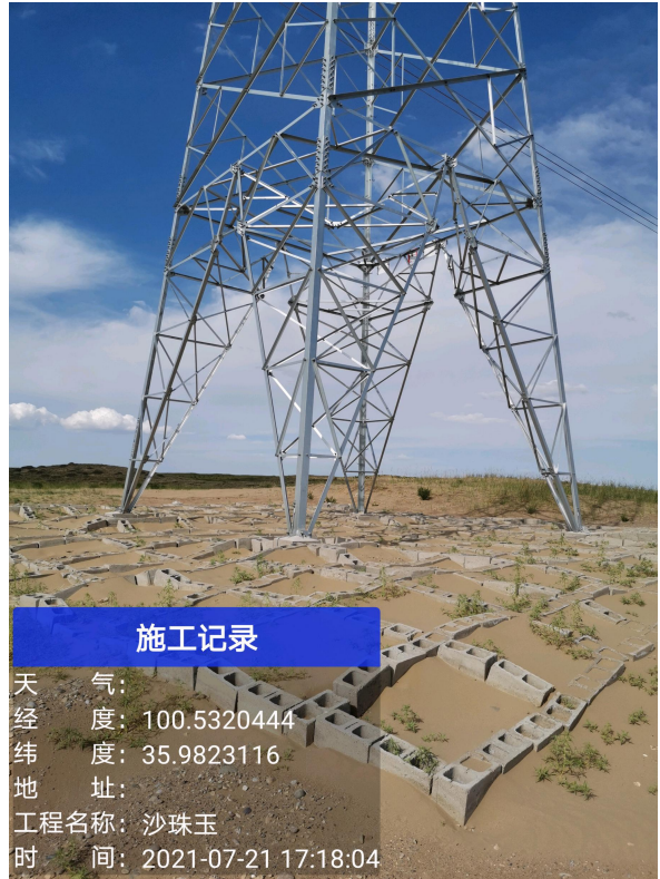
沙化区域石方格防风固沙及植被恢复措施
