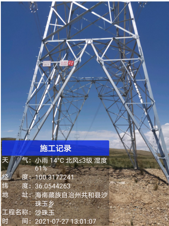
植被成活率及生长较好塔基
