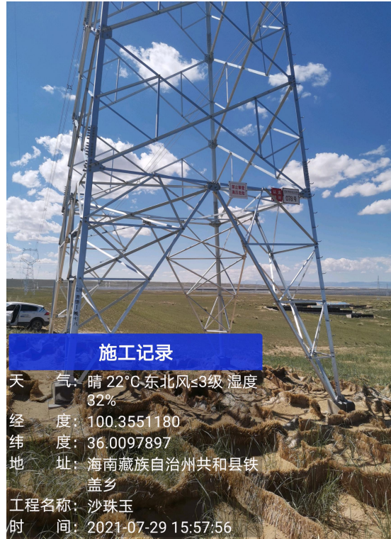
项目塔基外施工扰动区域（草方格布设）
