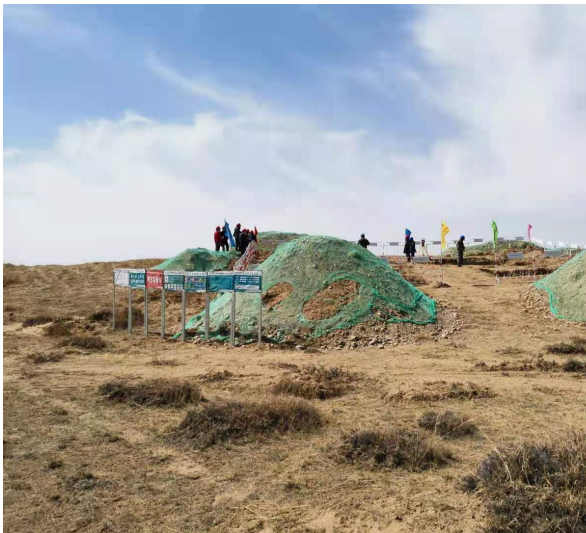
防尘网苫盖施工
