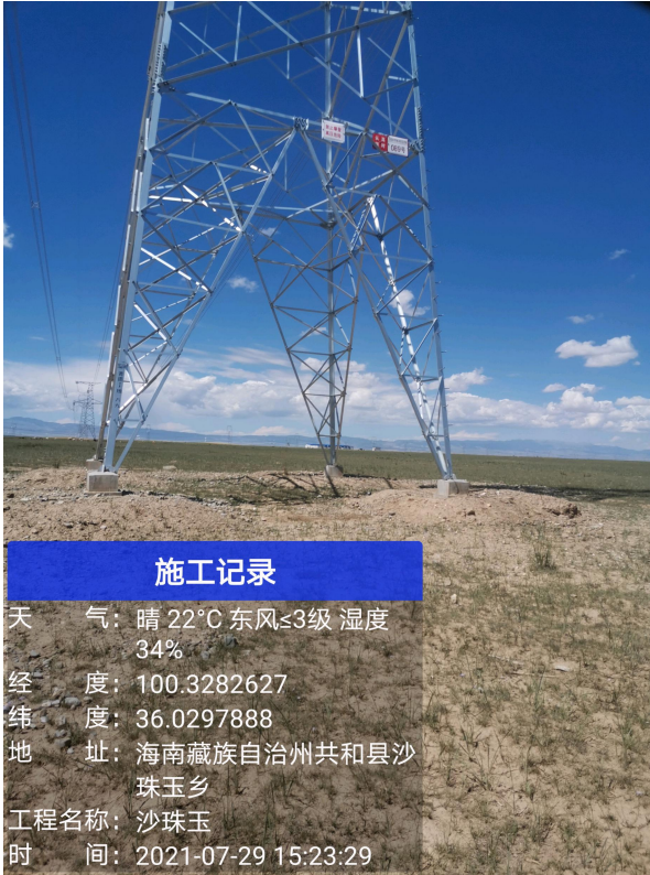
植被成活率及生长较好塔基
