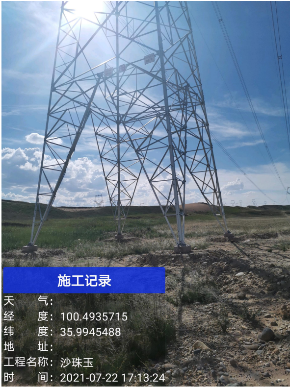
植被成活率及生长较好塔基
