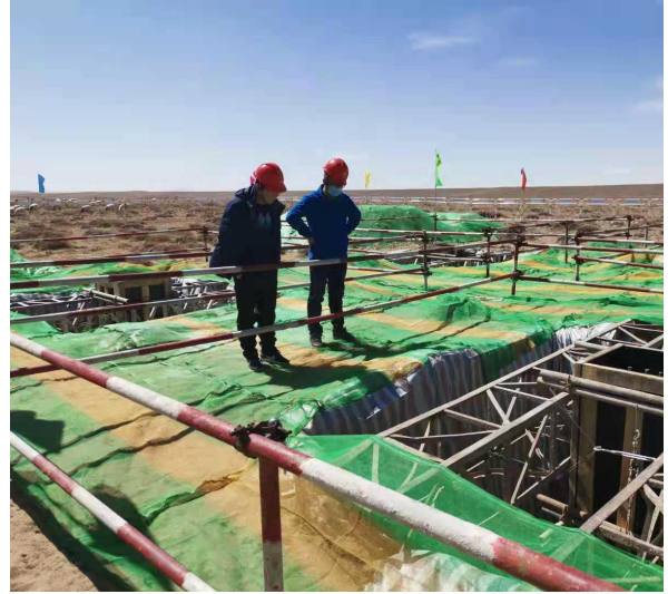
地面苫布苫盖施工
