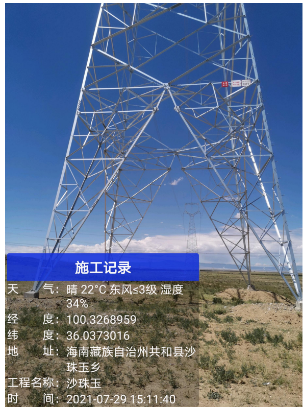
植被成活率及生长较好塔基
