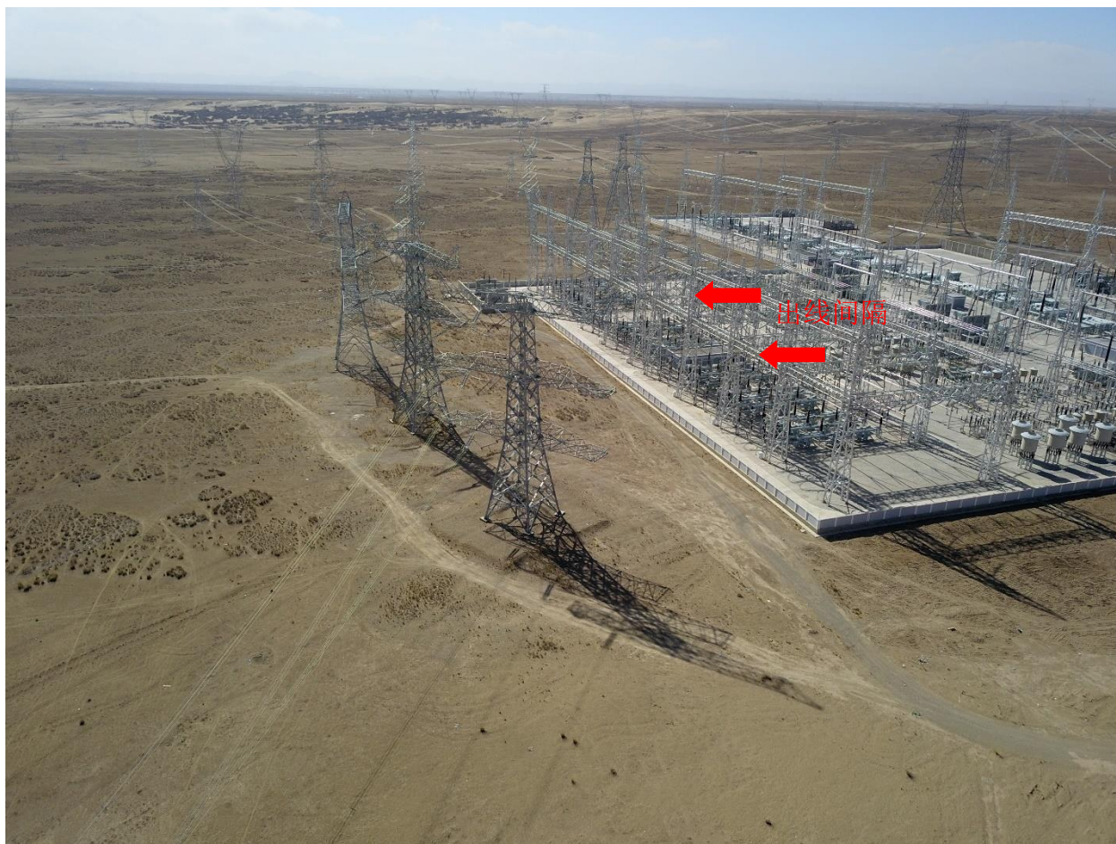
塔拉 750kV 变电站 330kV 侧出线地形地貌
