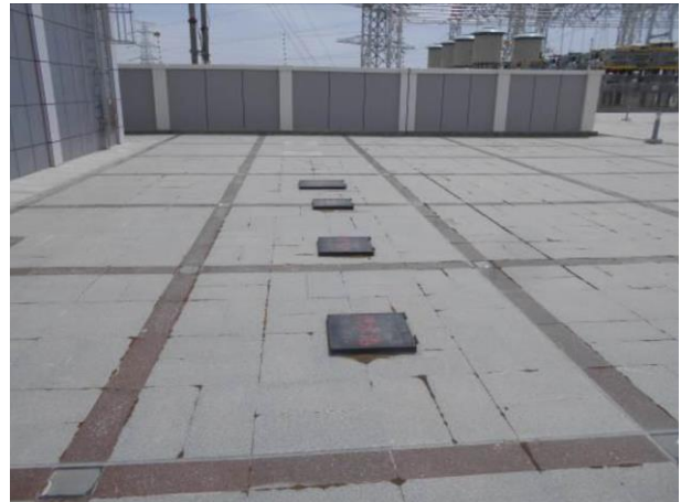
塔拉 750kV 变电站 地理式生活污水处理装置
