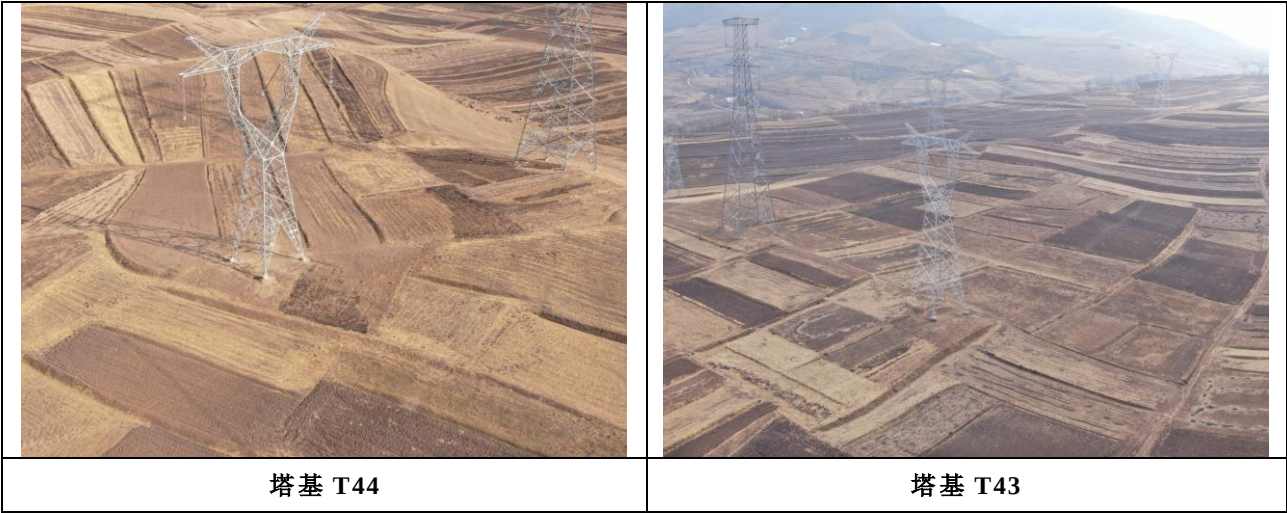
图 6-1 本工程输电线路临时占地及塔基环境现状情况
