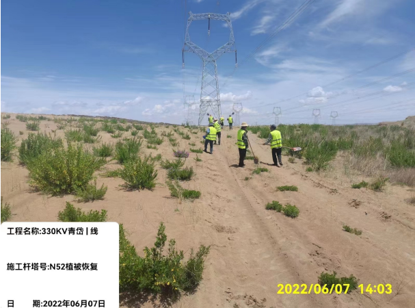
施工道路播撒草籽
