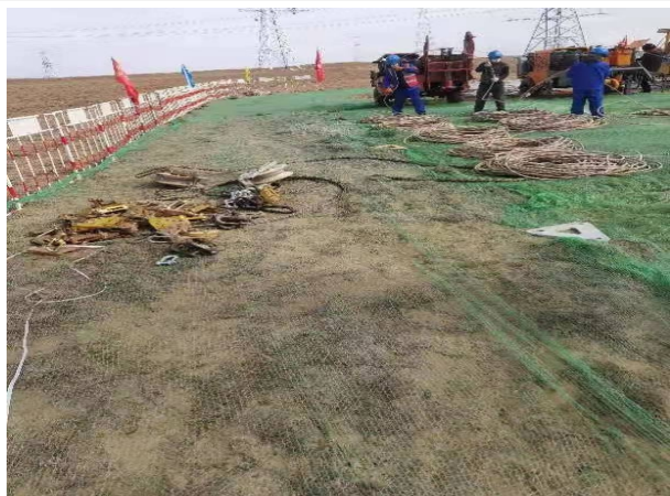
施工期施工道路彩旗
