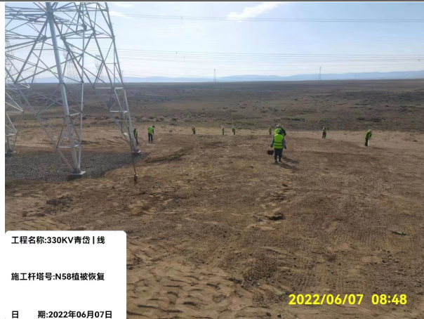
塔基周围播撒草籽
