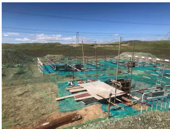
施工期苫盖措施
