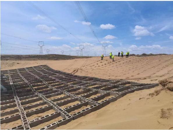
塔基周围播撒草籽
