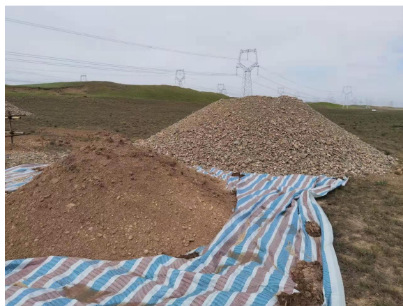
施工期彩条布隔离措施
