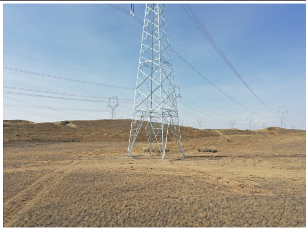
塔基施工处生态恢复现状
