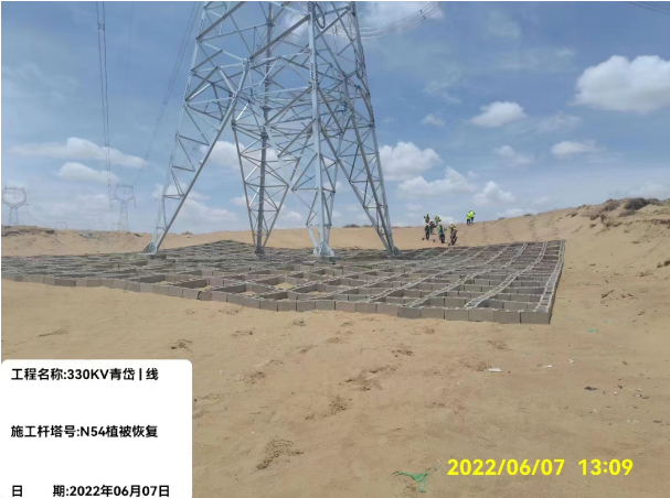
石方格沙障防风固沙措施
