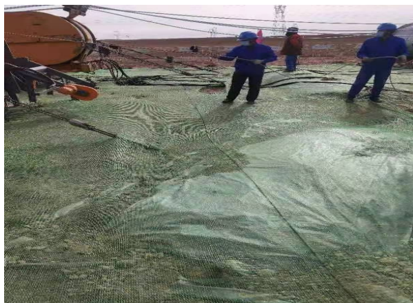
施工期牵张场苫盖措施
