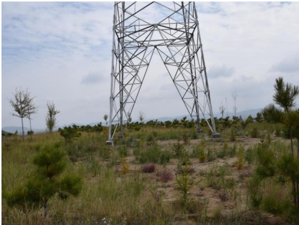
宁树 I 回 32#塔基
