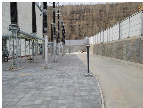
站内道路硬化
