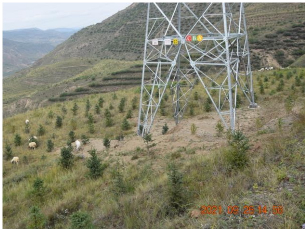
宁树 I 回 27#塔基
