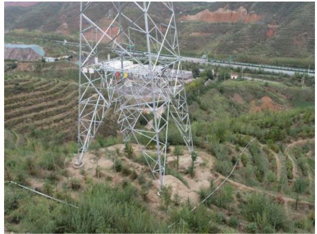
宁树 II 回 46 塔基
