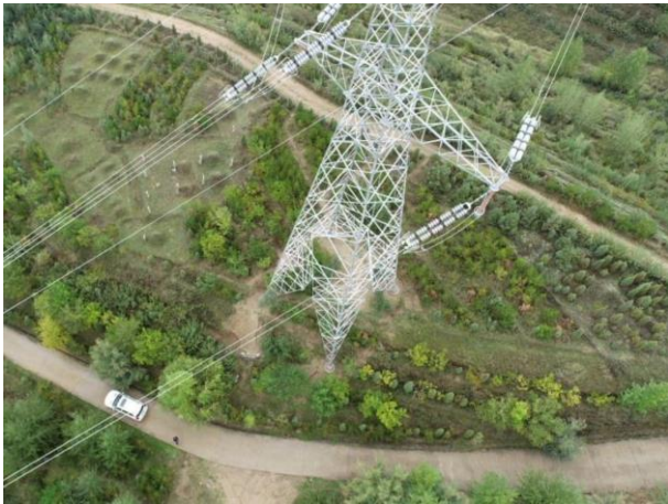
宁树 I 回 48#塔基
