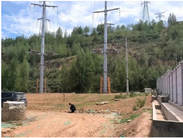
站外施工临建拆除、平整绿化
