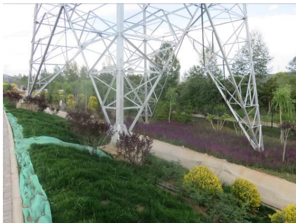
同塔双回 8#塔基
