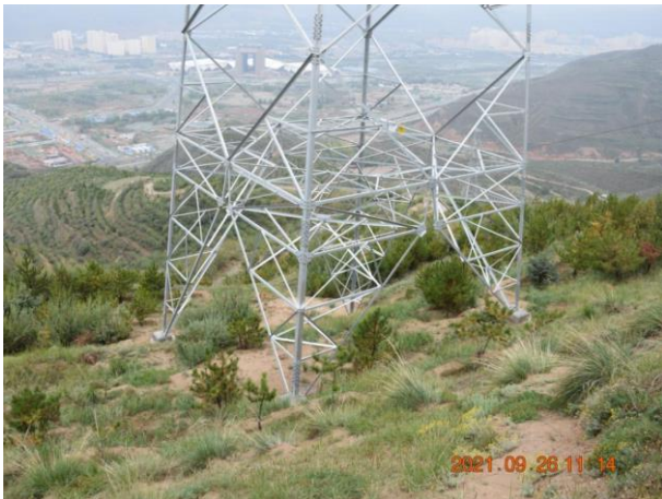
宁树 I 回 43#塔基
