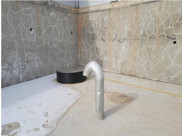
主变事故油池
