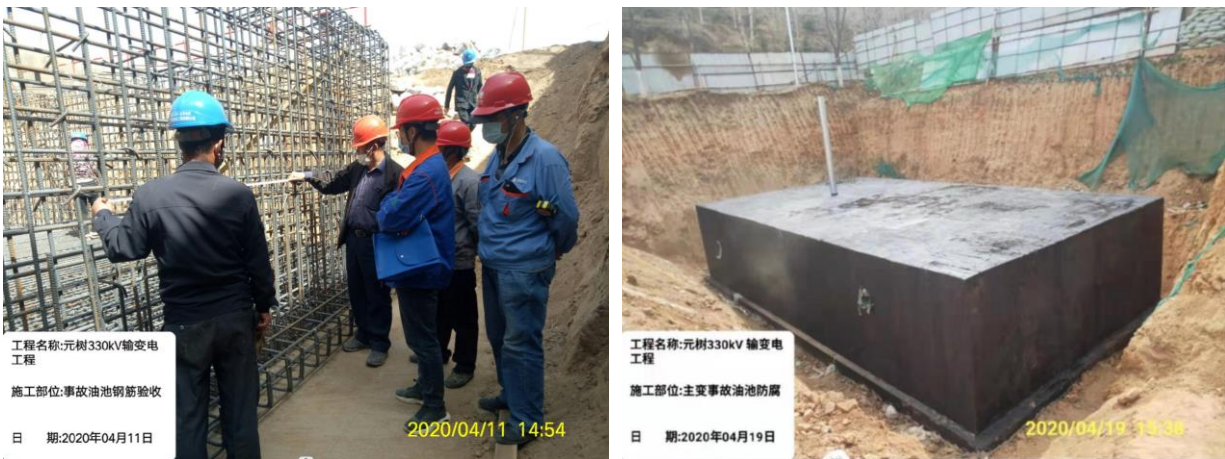
图 11.2-1 元树 330kV 变电站事故油池施工部分图片
