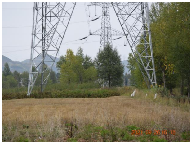
宁树 I 回 3#塔基
