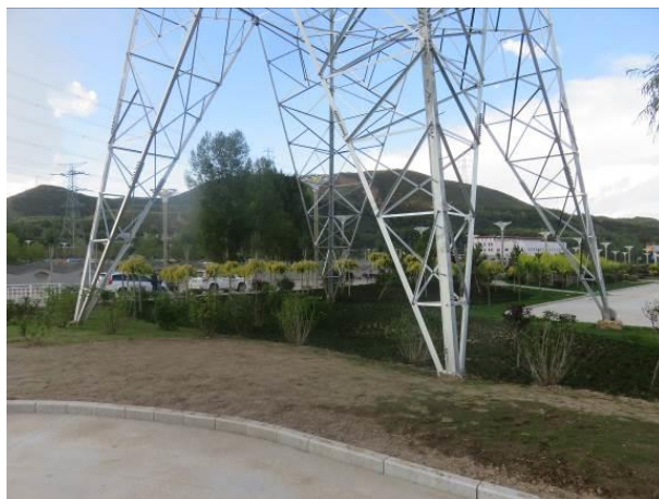
同塔双回 9#塔基
