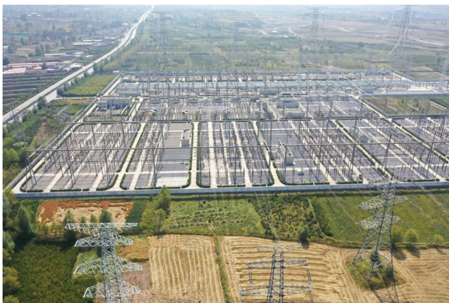
图 6-3 西宁 750kV 变电站本期站外生态恢复情况
