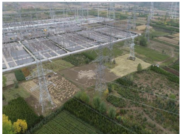
西宁变本期出线侧植被恢复
