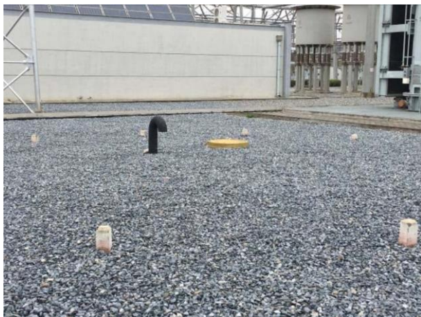
主变事故油池
