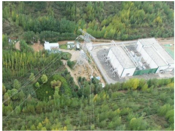
变电站外部植被恢复情况
